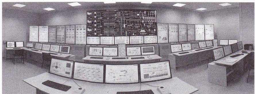
Рис. 1. Аналитический тренажер реактора БН-800
